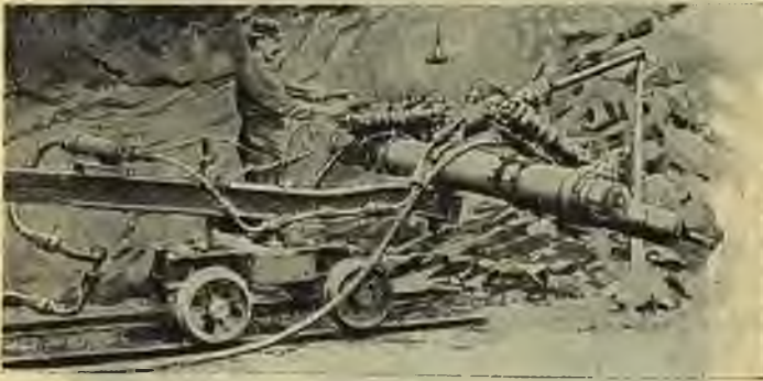
Гидравлическая сверлильная машина въ дѣйстви. На рисункѣ видно, какъ изъ дыръ, которыя буравятъ сверла, льется вода.
