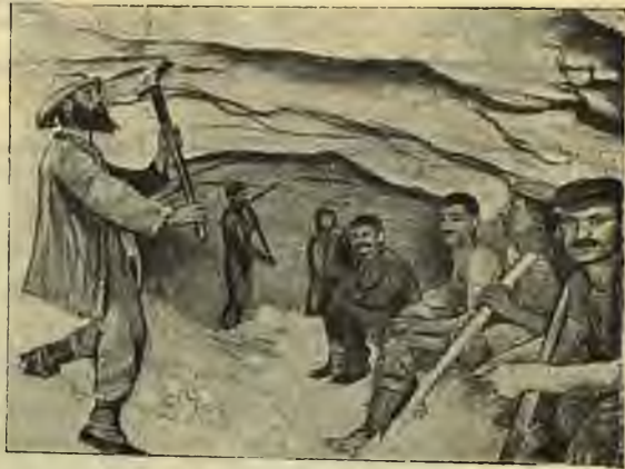
Работа надъ расширеніемъ туннеля.
