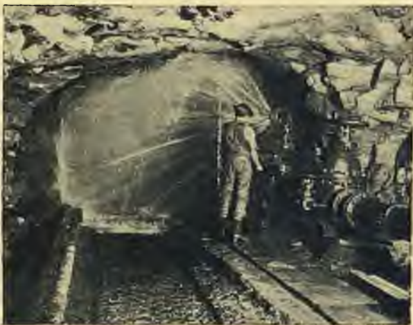
Освѣженіе воздуха струей холодной воды.
